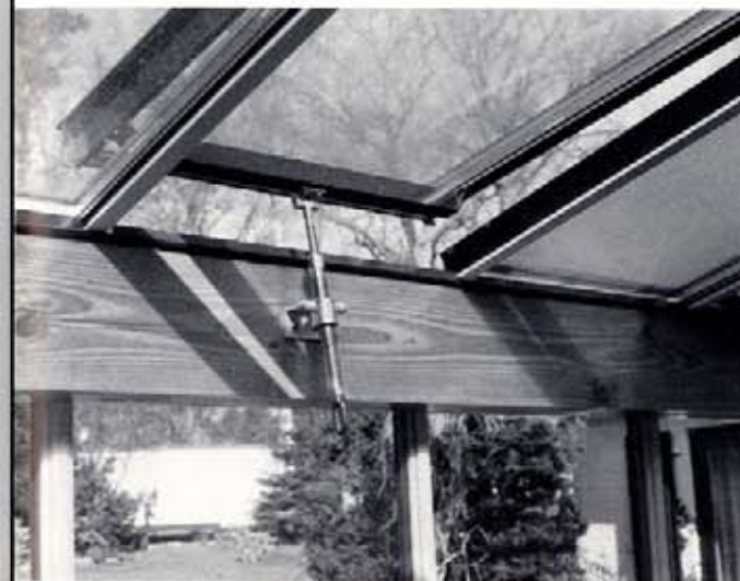
222 Die Lüftungsflügel im Dach lassen sich einfach per Hubspindel öffnen und schließen.
