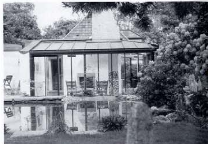
217 Der gläserne Anbau aus wartungsfreien, selbsttragenden Paneelen fügt sich in den bestehenden Garten. Der neu angelegte Teich dient hier zum Ausgleich des Kleinklimas.
