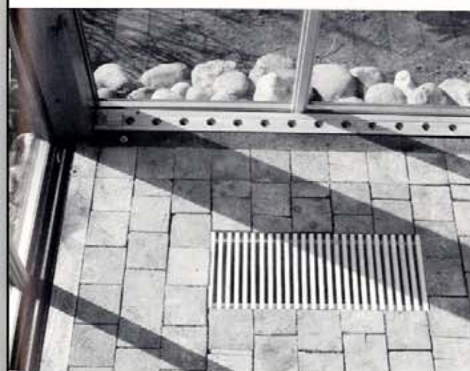
224 Der Fußboden: Hirnholzpflaster in eine Lehmschicht verlegt mit eingelassener, abnehmbarer Bodenentlüftung. Unten am Glaspaneel ist die schließbare Zuluftschiene aus Holz zu erkennen.
