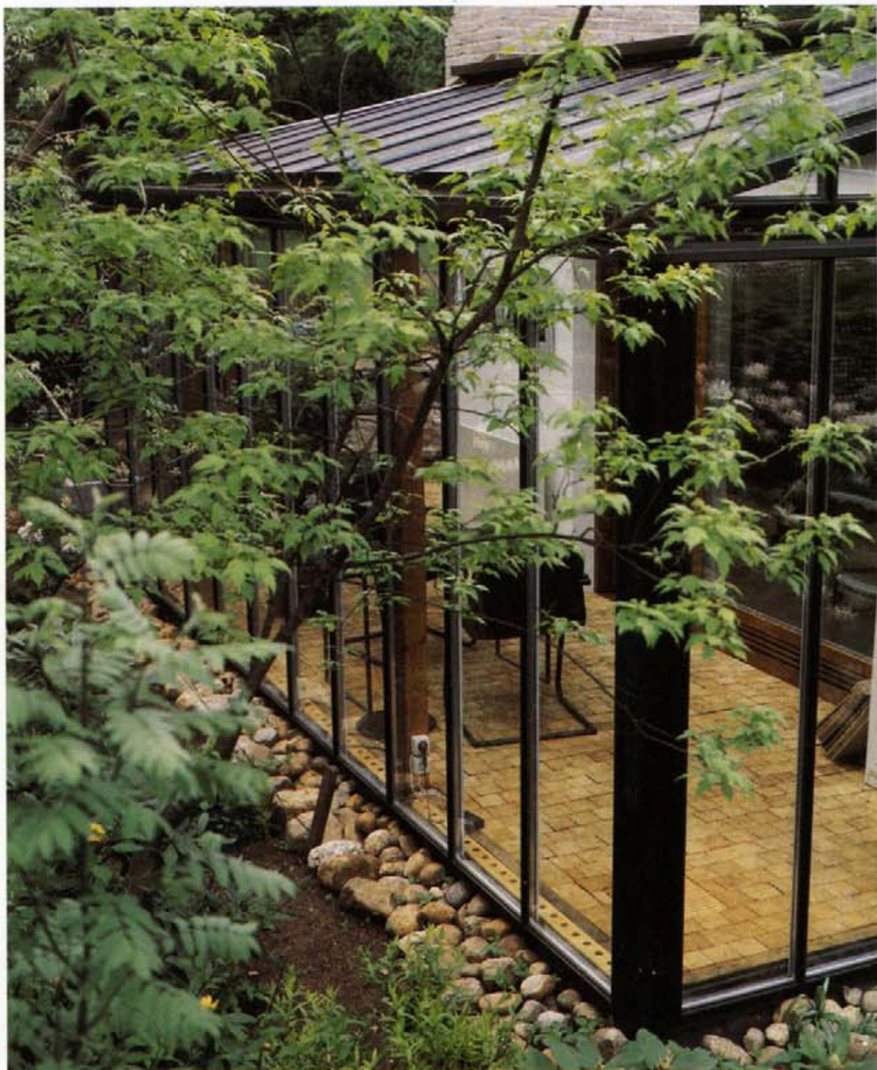
221 Der Blick von der Ostseite: Sommergrünes Laub sorgt für Sonnenschutz des wohnlich warmen Wintergartens. Die schließbare Dauerlüftung (runde Öffnungen) unten an der Schwelle und im First verhindern eine Überhitzung. Praktisch ist der schmale Kiesstreifen als »Schmutzfänger« bei Regen.
