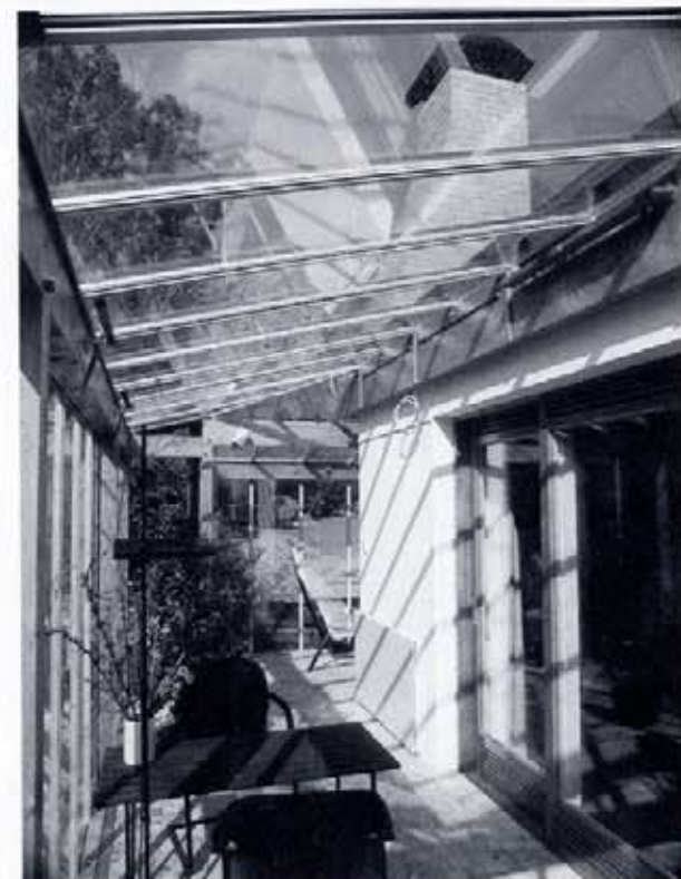
218 Eine gute Ergänzung: freundlich weiße Wandflächen und der warme Holzton des Fußbodens.
