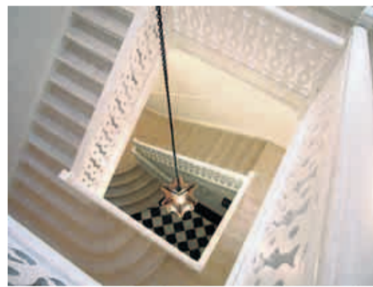
In dieser Villa mit mehreren Einheiten erstrahlt das historische Treppenhaus nach dem Rückbau durch das Architekturbüro wieder in altem Glanz.
